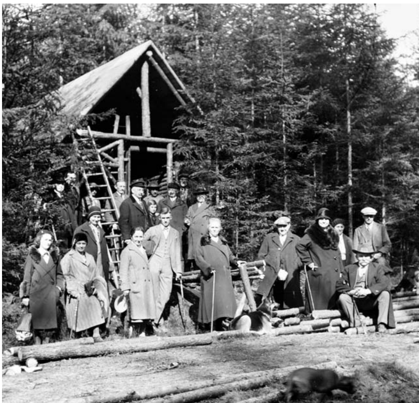
Im Mai 1931 errichtete der Verein eine Schutzhütte im Teufelstal. Links das Foto beim Bau der Hütte, rechts vorn sitzend F. Louis Klaus „dr Vater“.
